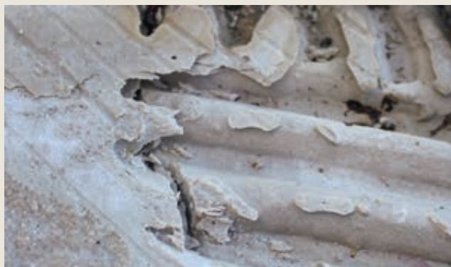
Figur 3: Dobbellinging med flytlim er alene ikke nok, flisen må presses ned så rillene flyter utover, og slik at luften presses ut og ikke danner luftlommer
