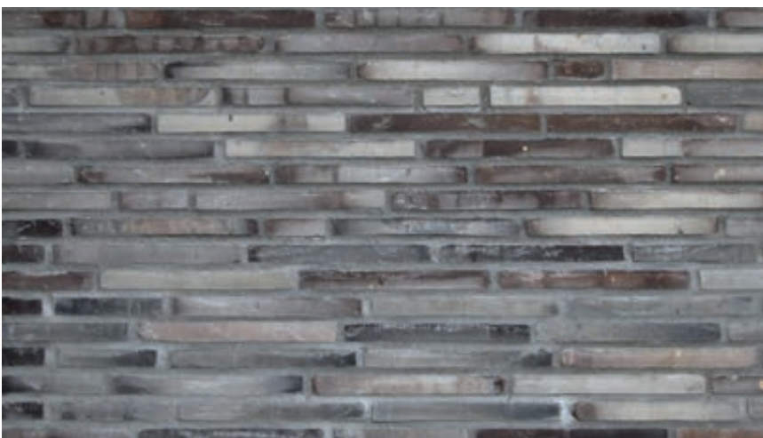
Terca Bemmels Blauw Light grey waterstruck – 400x100x40mm– understreker det monolittiske byggevolumet. Teglsteinens farge megler også mellom det lyse uttrykket på de nye bygningene mot nord og de tradisjonelle verkstedbygningene mot sør
