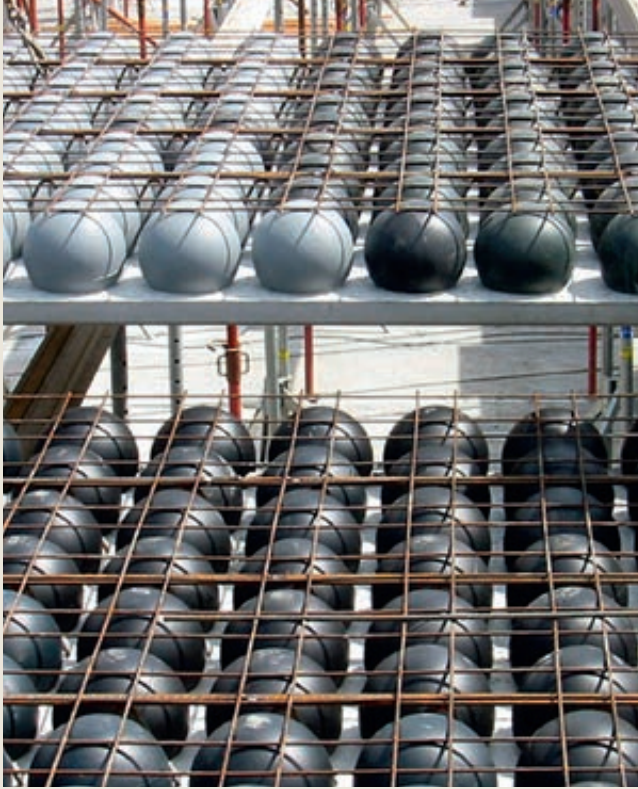
Prefabrikkert bunnplate i betong med ferdigmontert armering og plastballer. Øvre del utstøpes på byggeplass
