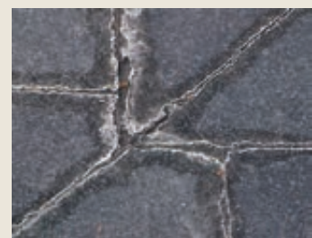
Figur 9: Typisk kalkutfelling på fuger utendørs
