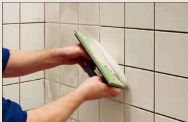
Fargevariasjoner i fugene kan unngås ved korrekt blanding av fugemasse samt kontroll med fukt- og temperaturforhold
