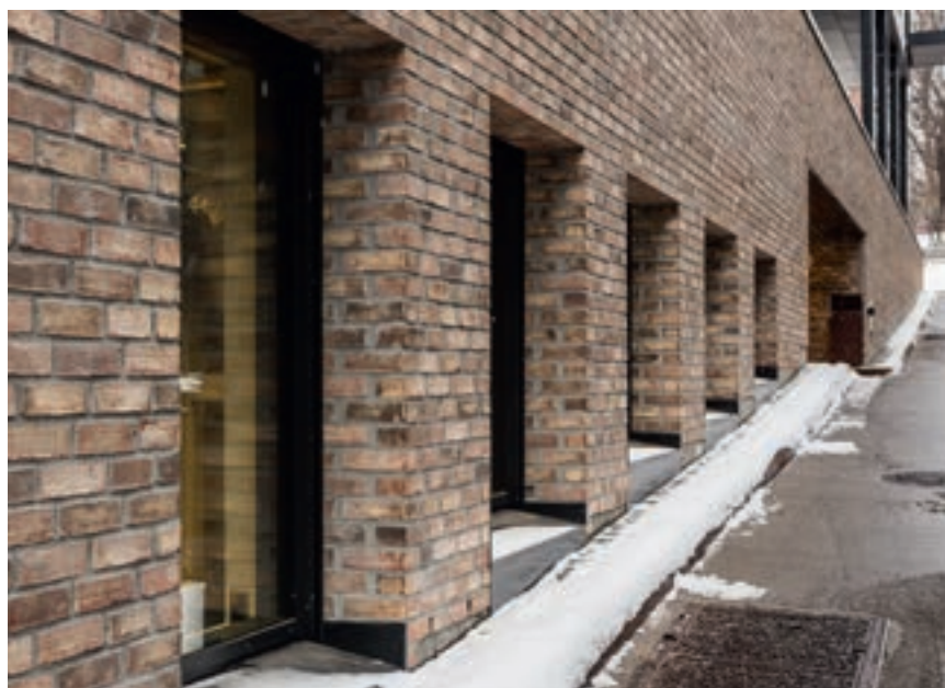
Sokkeletasje med dype vindussmyg
