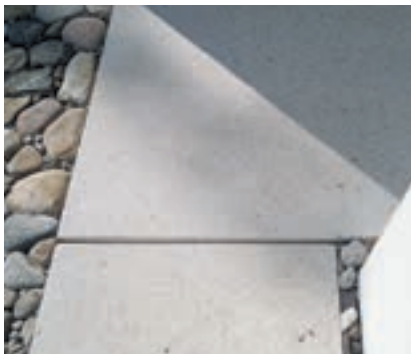
Utvendig dekke i lys slipt betong med Kragerøkvarts som tilslag (foto: mmw)
