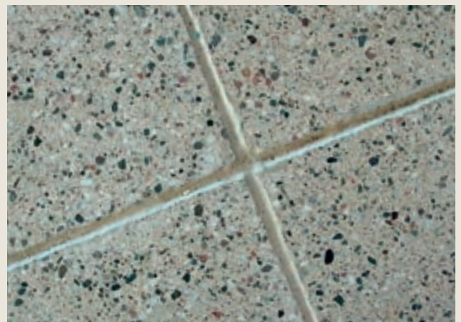
Det ble saget rissanvisere mot søyler Bildene viser rissanvisere med og uten fugemasse
