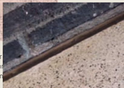
Fuge langs vegg fylt med hhv. lys og mørk fugemasse
