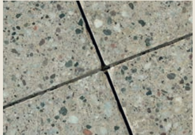
Det ble saget rissanvisere mot søyler Bildene viser rissanvisere med og uten fugemasse
