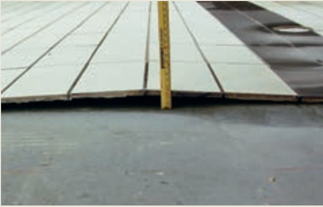
Figur 3: Fliser som står i bue indikerer at det er deformasjoner i betongunderlaget.
