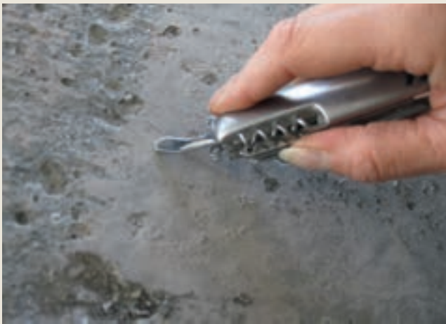
Figur 4: Sementhinne og annen forurensning må fjernes før liming starter
