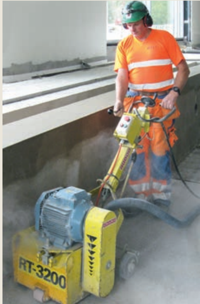
Figur 5: Bruk utstyr som lager en ru overflate og samtidig fjerner smuss og forurensning – sandblåsing eller kuleslyngemaskin (blastring)
