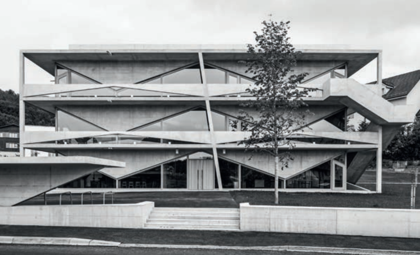
Fra nordøst. Spenningen mellom det massive lukkede og lette åpne er et resultat av kreftenes løp i dekker, vegger, støtter – den midtre trukket skrått til side som en gardin for å gi plass for inngangsdøren.
