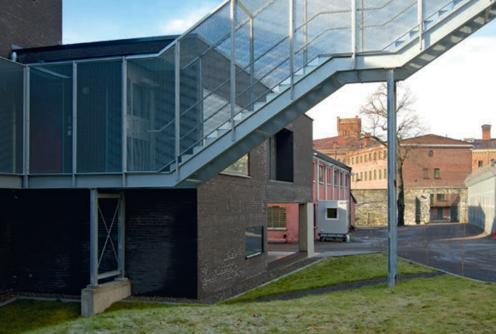
Inngangspartiet sett fra øst. I bakgrunnen ser man en del av 'Kistemuren' i naturstein, og bak denne det vifteformede Botsfengselet fra ca 1850 i rød tegl.
