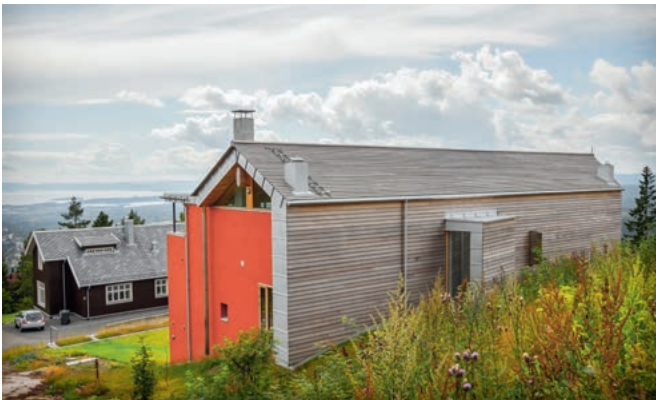
Sett fra nordøst. Nordveggen henger sammen med saltaket i materialbruk, sedertre som etter hvert får en grå patina
