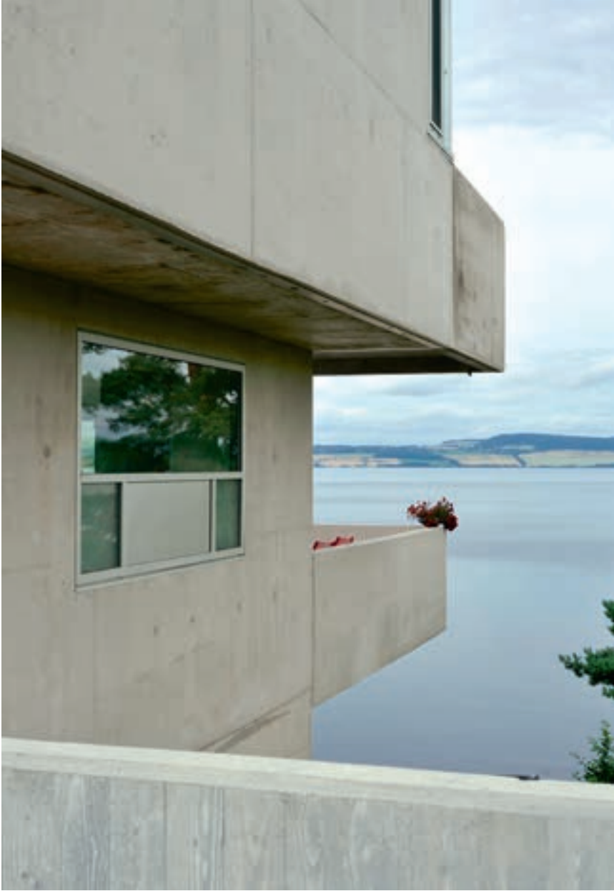
Den plasstøpte sandwich-konstruksjonen muliggjør forholdsvis store utkragninger av balkonger og terrasser utvendig
