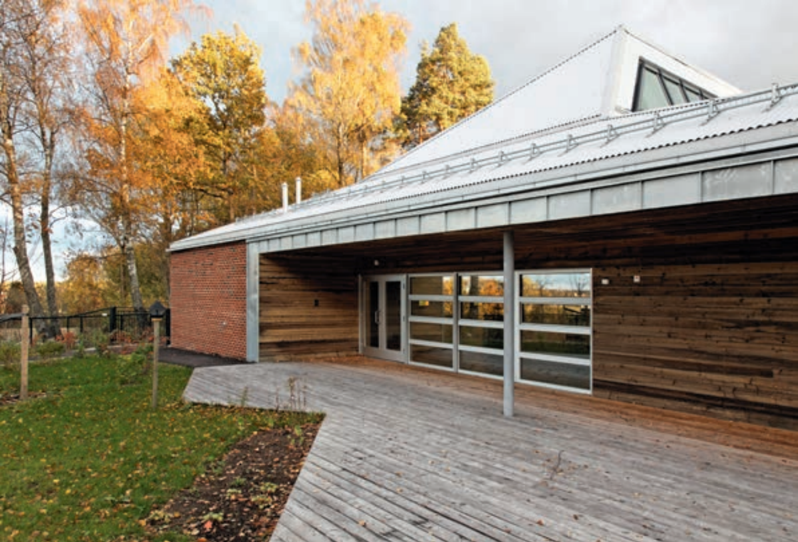
Relasjonen til den eldre bebyggelsen opprettes ved slektskap i struktur, takform og fasadematerialer – rød tegl og trepanel
