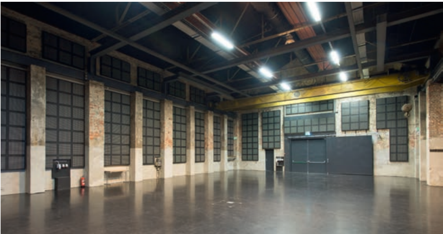
Den gamle industrihallen er rehabilitert og vegger støvbundet. Traverskrana måtte sveises i fast posisjon, men kan brukes som lysrigg e.a.
