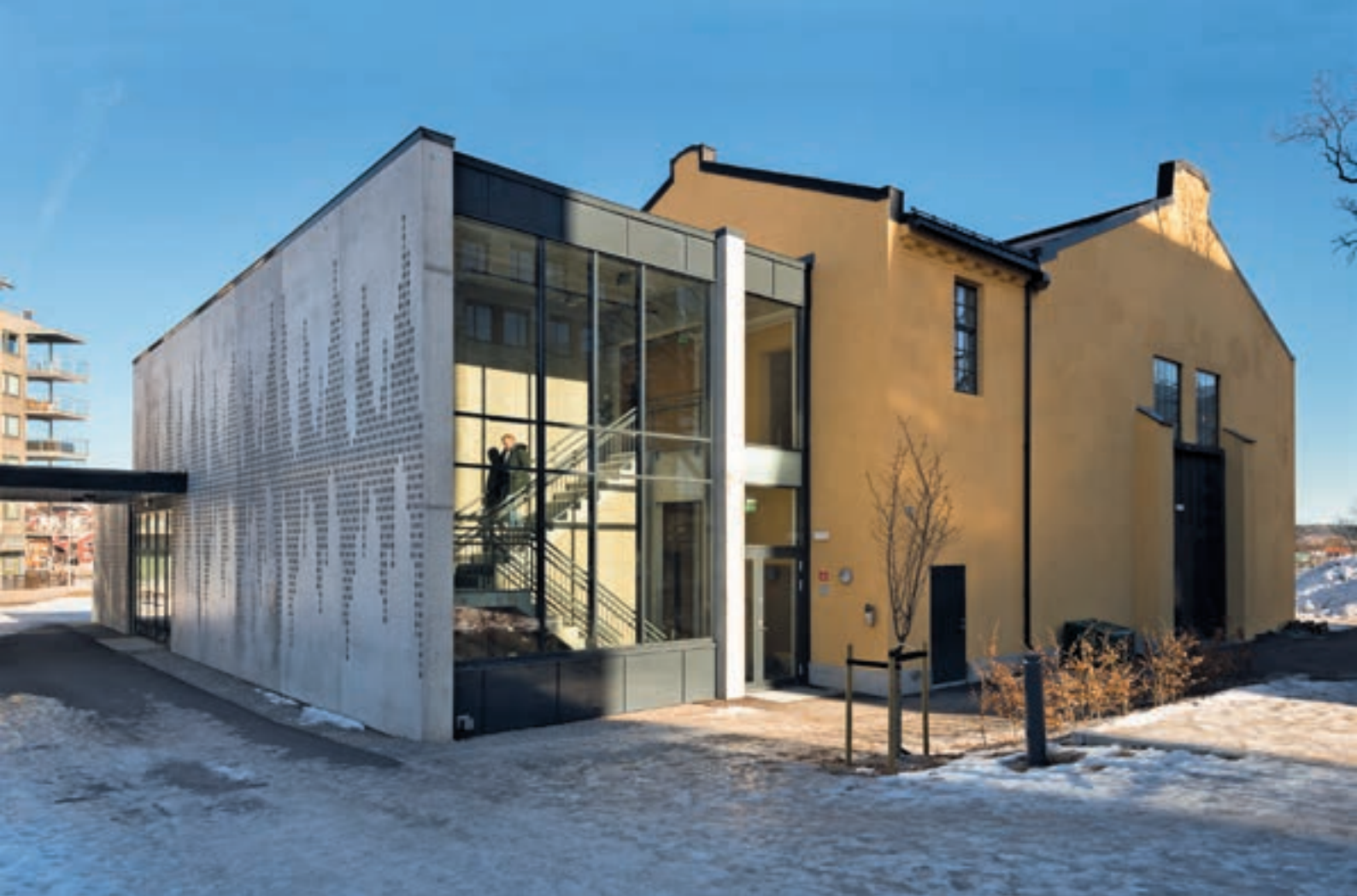
Aktivitet i Støperiet er synlig fra utsiden. Trappen forbinder greenroom og scene.
