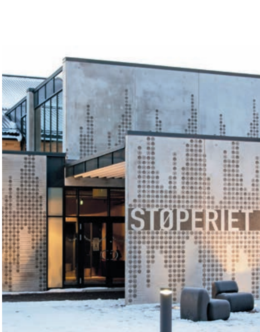
Hovedinngangen mellom betongskivene
