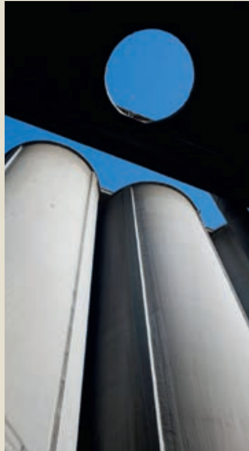
Utslipp av klimagasser fra sementproduksjon reduseres bl.a. ved overgang til alternativt brensel og rensing av SO 2 og NO x . I Norcem har man også store forventninger til det nystartede karbonfangstprosjektet Foto: Fotografjengen
